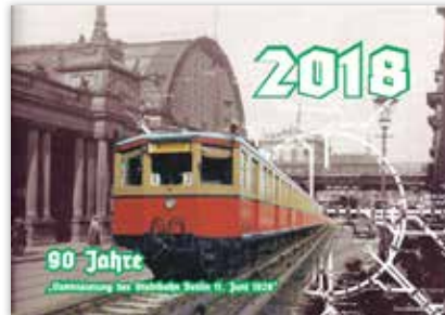
Foto: BSW Gruppe Bahnstromanlagen
